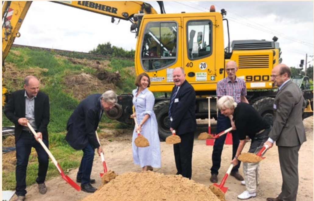
Spatenstich für Haltepunkt Stendal-Hochschule im Sommer. Mitte 2022 soll die neue Station fertig werden.
